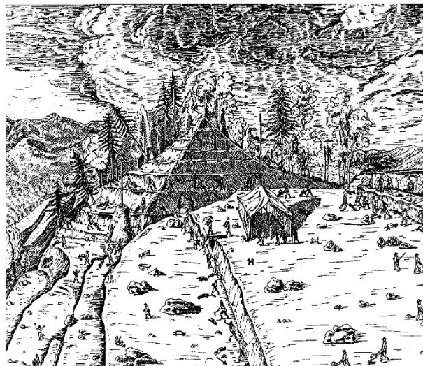
Bild 2. Arbeiten am Kanderdurchstich, Skizze von T. Bürgin nach einem zeitgenössischen Gemälde von 1714.
